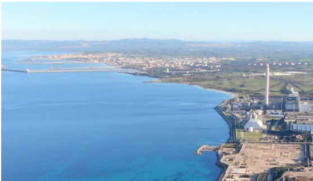
In primo piano l'area dei vecchi gruppi 1 e 2 a olio demoliti
